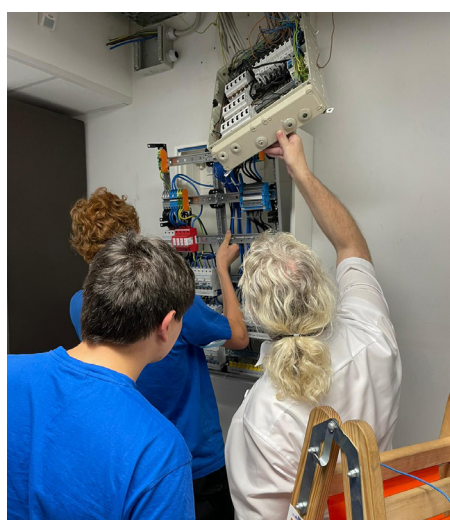
Unter dem strengen Auge der Ausbilder wurde fast die gesamte Hauselektrik erneuert
