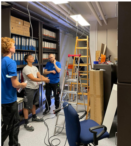
Gut gemacht: Per Bewegungsmelder schaltet sich die neue LED-Beleuchtung automatisch ein
